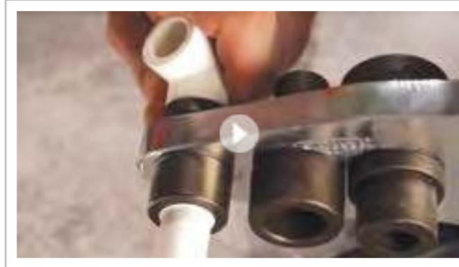
Монтаж полипропиленовых труб.
